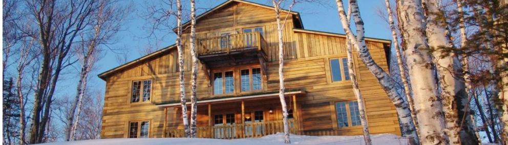
©Pourvoirie Cap au Leste
